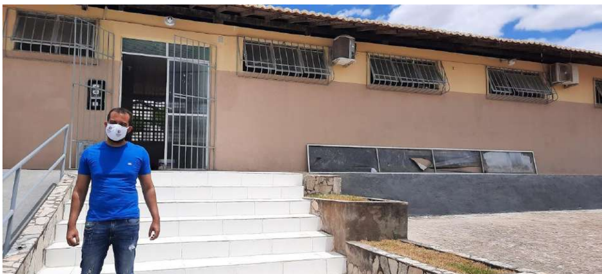
DEZEMBRO/2020 – MANUTENÇÃO DA USF JOSÉ RENATO VIEIRA BRANDÃO
