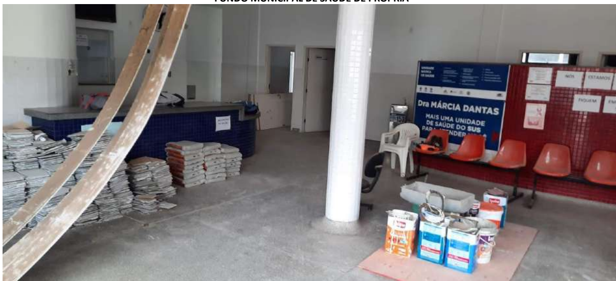
29/12/2020 – MANUTENÇÃO DA USF DRª MÁRCIA DANTAS
