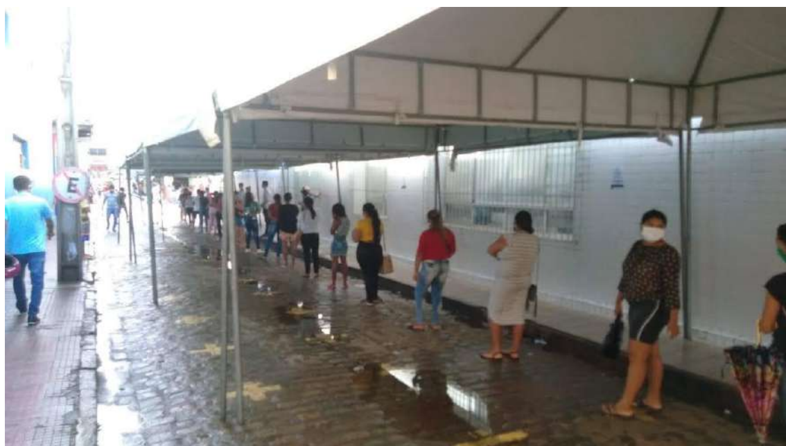
21/05/2020 – COLOCAÇÃO DE TENDAS NAS LATERAIS DA AGÊNCIA DA CAIXA ECONÔMICA PARA ORGANIZAÇÃO DAS FILAS RESPEITANDO O DISTÂNCIAMENTO SOCIAL.
