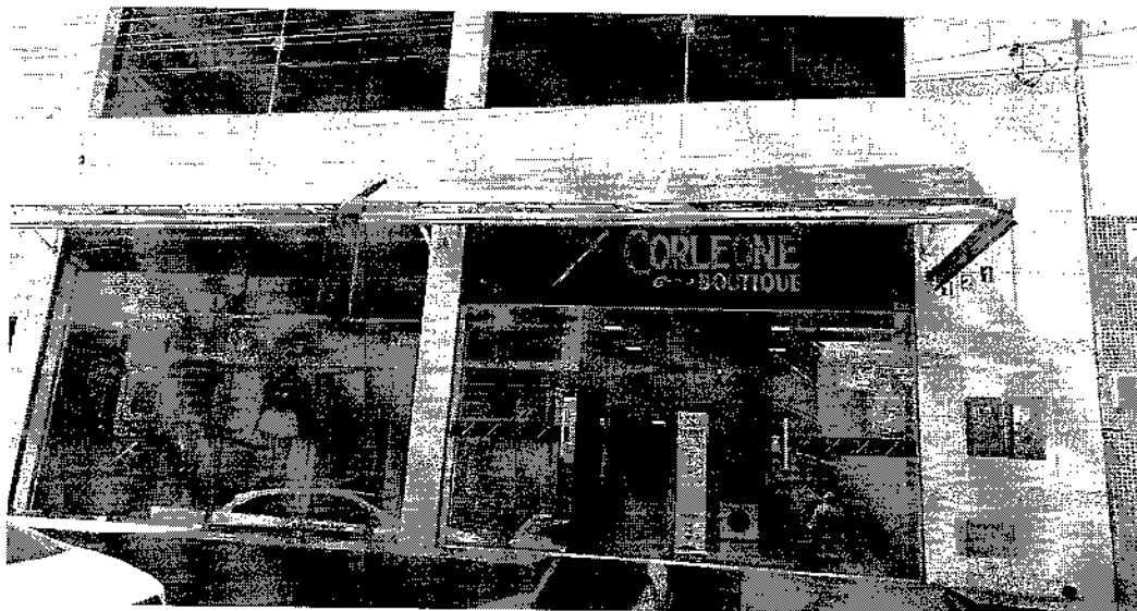
AMOSTRA Nº 05 - CORLEONE BOUTIQUE - RUA DR. COSTA FILHO, 121, CENTRO - PROPRIÁ/SE
