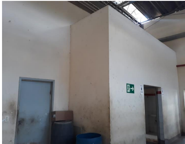
Imagem 35: Acesso aos banheiros e depósito.
