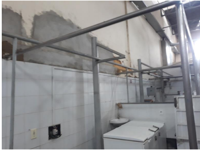
Imagem 04: Reboco danificado.
