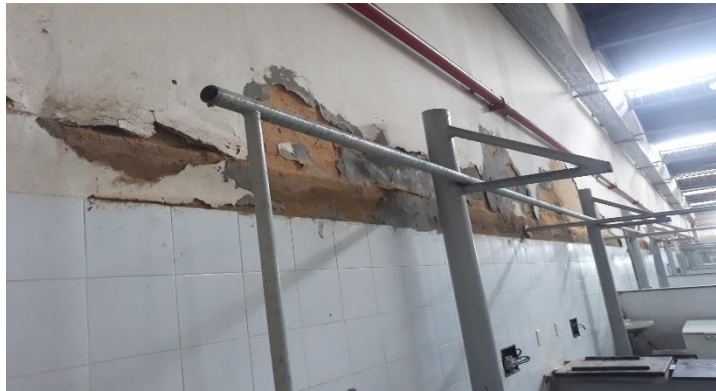
Imagem 07: Salitre na parede.
