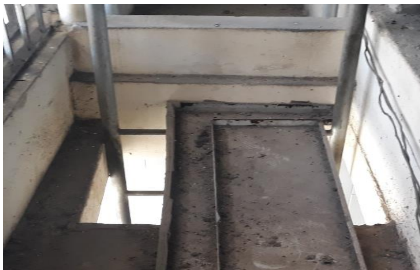
Imagem 31: Acesso aberto para cobertura.
