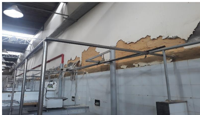
Imagem 06: Salitre na parede.
