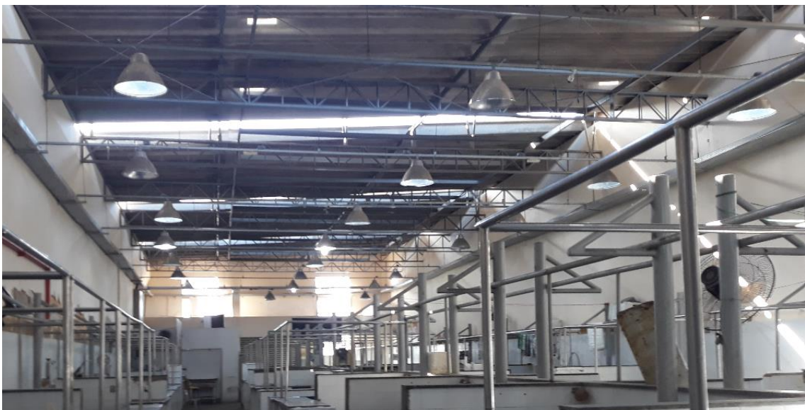
Imagem 28: Condição atual da iluminação.
