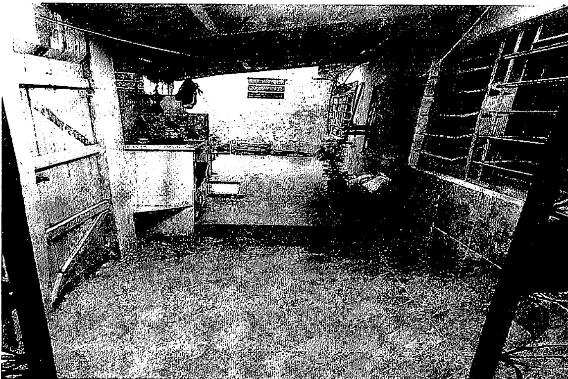
Foto 12: Área de serviço (área externa)
